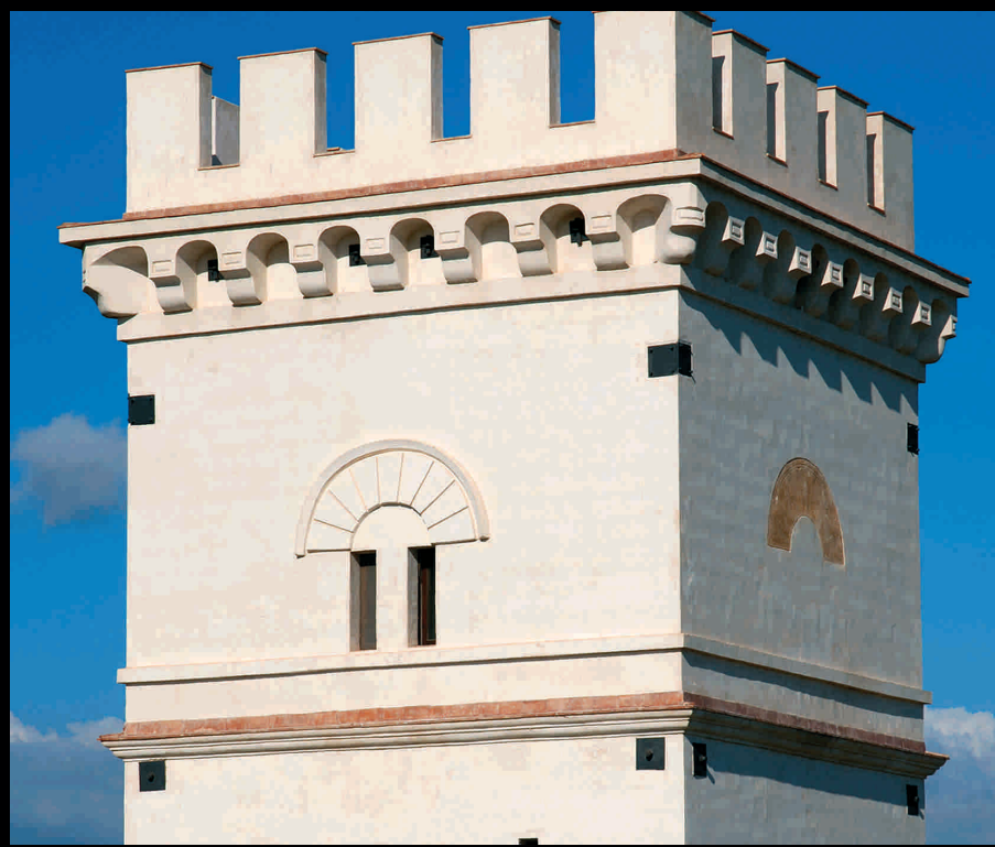
Torre Galvaga - Tour Galvaga
